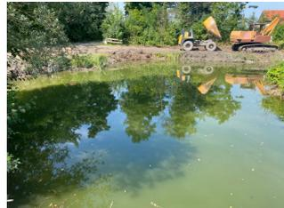
Erste Arbeiten wurden bereits am 21. August durch die Fa. Hartl gestartet. Zirka 400m<sup>3</sup> schlammhaltiges Material konnte ausgeräumt und auf der Prachfläche neben dem Biotop zur Trocknung zwischengelagert werden. Nach einer Prüfung mittels Labor wird über die weitere Verwendung entschieden.
