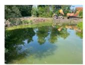
Erste Arbeiten wurden bereits am 21. August durch die Fa. Hartl gestartet. Zirka 400m³ schlammhaltiges Material konnte ausgeräumt und auf der Prachfläche neben dem Biotop zur Trocknung zwischengelagert werden. Nach einer Prüfung mittels Labor wird über die weitere Verwendung entschieden.
